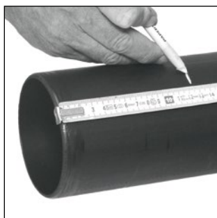
Označení požadované zásuvné délky
