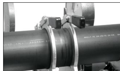
Správně připravené potrubí ke svařování
