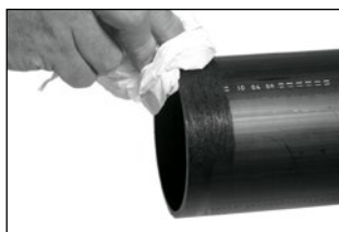
Ošetření konců potrubí PE čisticím přípravkem
