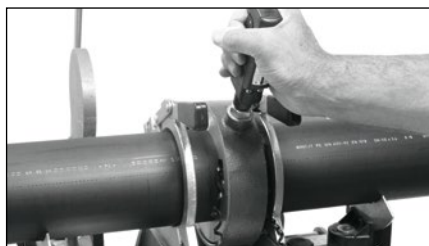
Srovnání konců potrubí integr. hoblíkem
