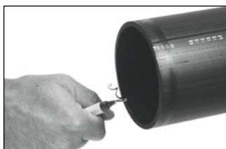
Odstranění otřepů a nerovností řezu
