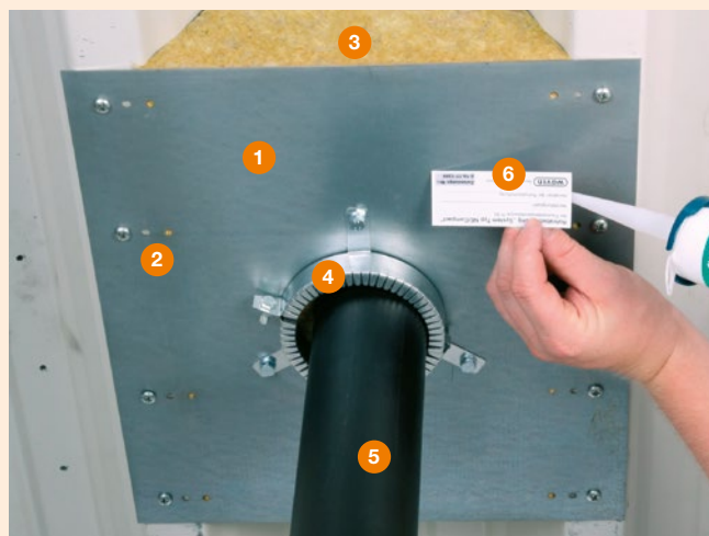
Protipožární set ke vtokům – příklad uložení
